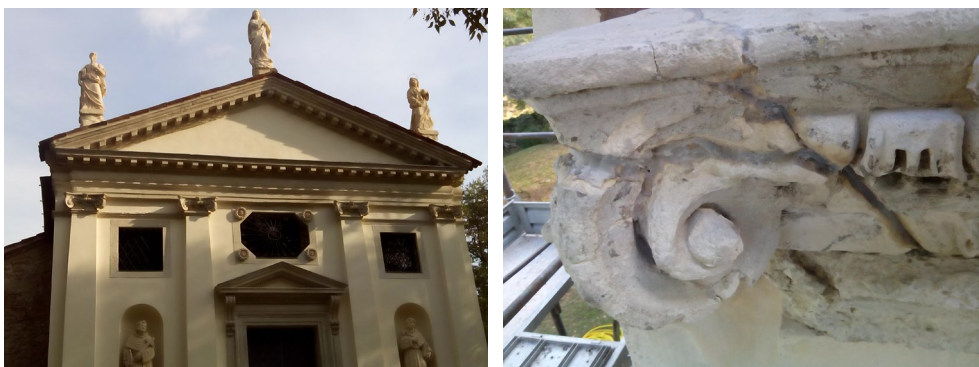
Figura 8: restauro della facciata della chiesa di S. Marco
