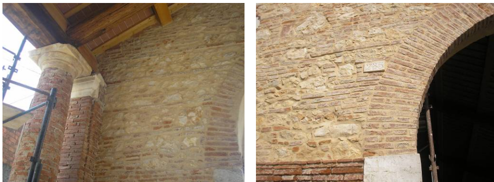
Figura 7: intervento di ristrutturazione di un edificio con cambio di destinazione d'uso, Vicenza Via Lobia
