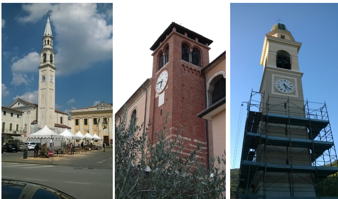
Figura 9: restauro del campanile di Camisano Vic.no(VI), di Barbarano Vic. no (VI), di Villaga (VI)
